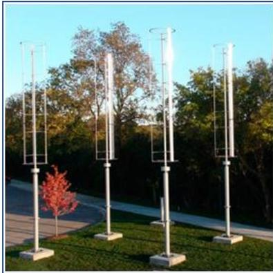
Encontraron que una configuración de turbinas de giro en el sentido de las agujas del reloj alternadas con otras de giro contrario incrementaba significativamente la velocidad de giro de todas ellas. La razón, según ellos, es que la presencia de las turbinas vecinas concentra y acelera el viento. Esta configuración es como sigue: una turbina de un tipo delante de una línea de dos turbinas del tipo contrario seguidas de una línea de tres del primer tipo y así sucesivamente.
