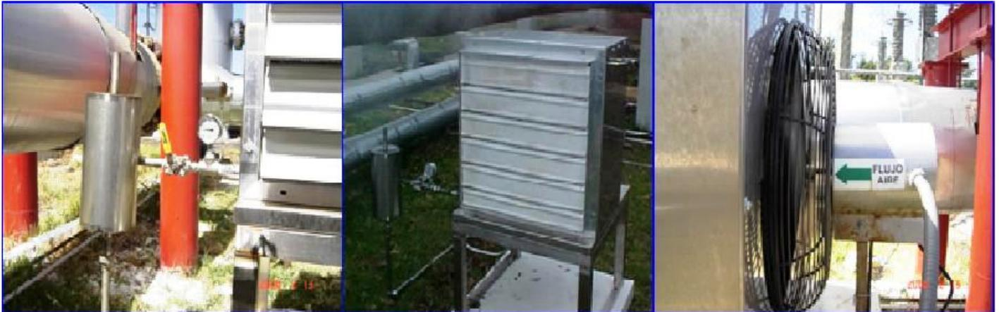
Fig. 3. Condensador de vapor enfriado por aire.
