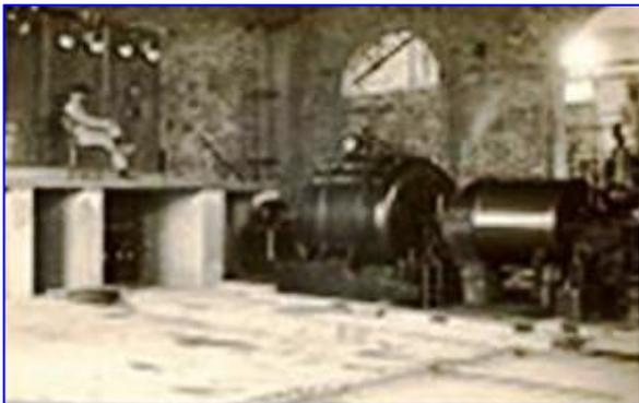
**1913.** Puesta en marcha de la primera y auténtica central geotérmica (foto de la izquierda), formada por un turboalternador de ciclo indirecto de 250 kW construido por la compañía electro-mecánica Franco Tosi. Este turboalternador podía funcionar con presiones de hasta 3 atmósferas absolutas a boca de pozo. Se pudo electrificar así todas las instalaciones de producción de boro de Larderello y la mayor parte de los centros habitacionales de la zona borífera.
