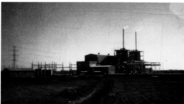
Figura 9. Instalación de chimeneas de gran altura par a evitar el problema de contaminación.
