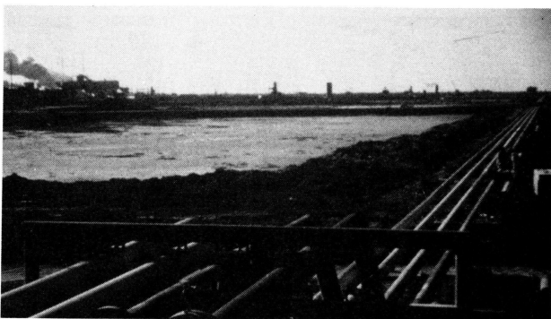
Figura 4. Tuberías de descarga.
