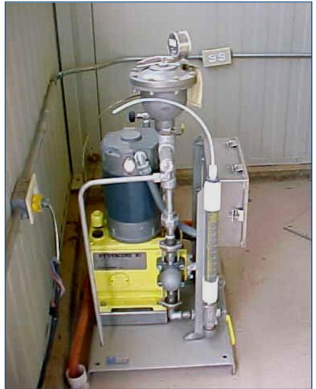
Fig. 4. Bomba para dosificar la solución
