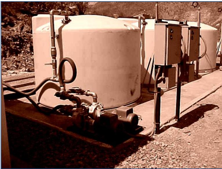
Fig. 5. Planta de dilución del NaOH
