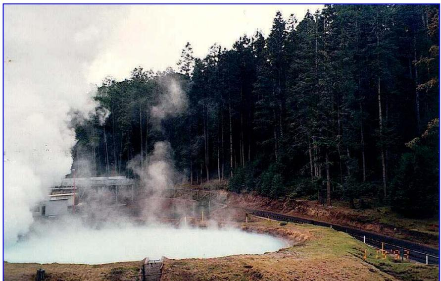
Fig. 5. Estanque de enfriamiento de aguas residuales antes de su inyección.
