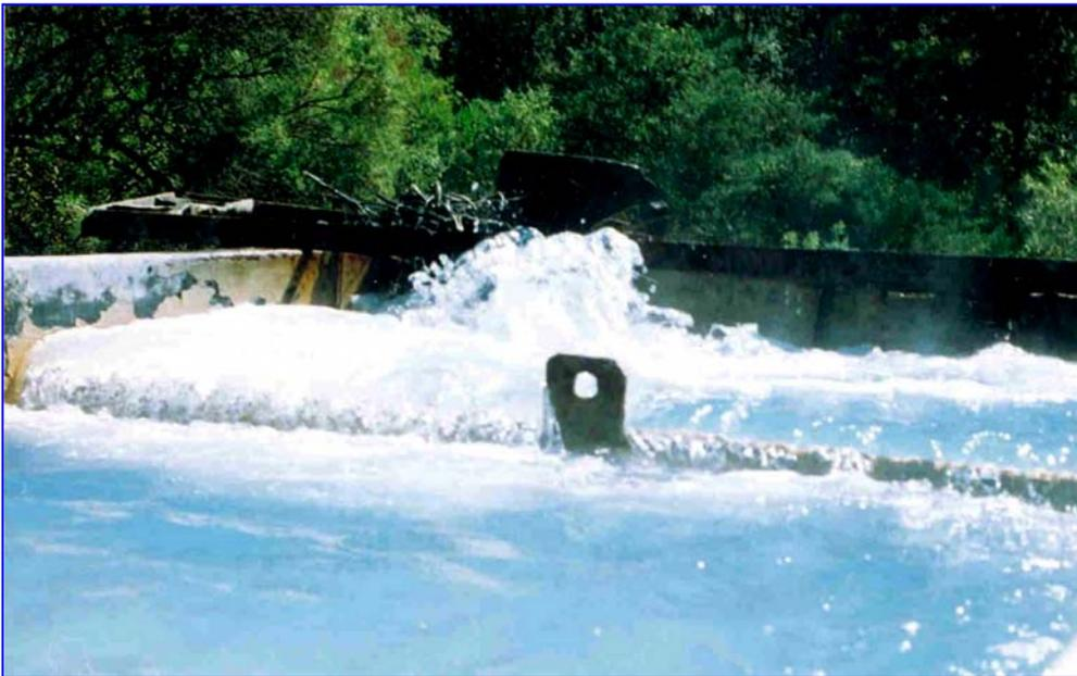
*Fig. 6. Caja rompedora de presión con dispositivo que relaciona el tirante de agua con el flujo*
